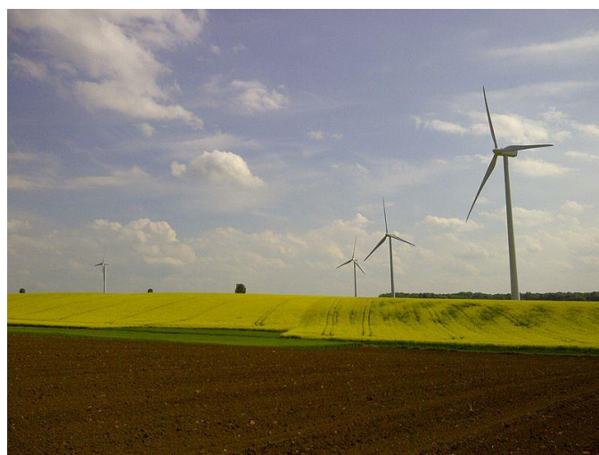
Eoliennes d'Is-en-Bassigny – Markentoine – Wikipedia
