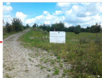
Station d'épuration par filtres de roseaux
