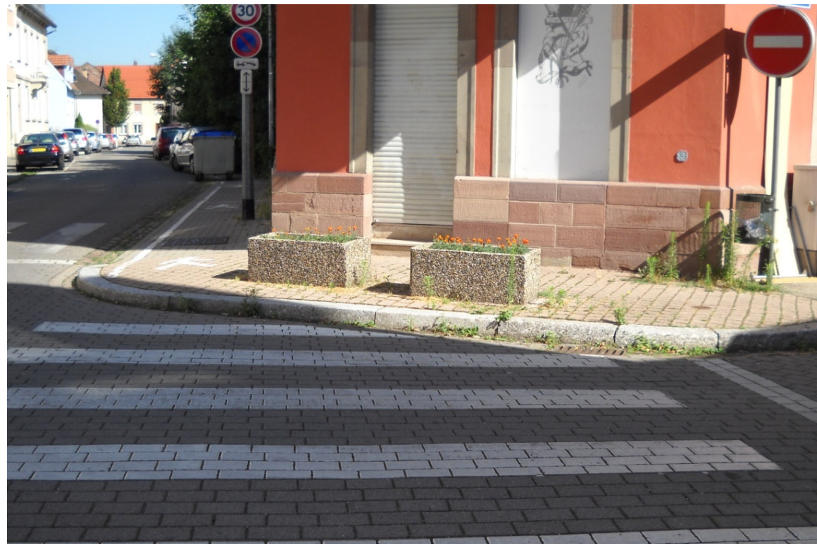
Passage piétons neutralisé par excès de protection contre les véhicules.
